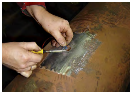
Fig. 7 : installation d'une jauge de contraintes sur un arbre.
